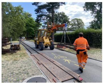
Seit 2001 sind wir bei jeder Ausgabe des "Züri-Fäschts" dabei. Am 1. Juli war Gleis legen angesagt. Die Arbeiten kamen trotz des sehr warmen Wetters gut voran: Gleisjoche verlegen, diese mit Laschen verschrauben, die gesamte Strecke mit Holzlatten unterlegen (zur Vermeidung von Spuren im Asphalt), Bahnübergänge bauen und alles mit Baustellenlampen und -latten sichern.
